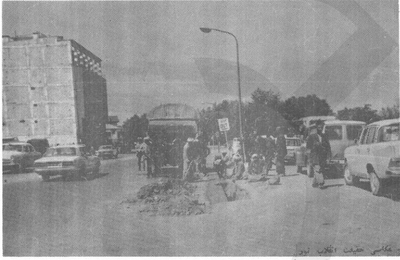
نمایی از ترمیم پیاده رو های شهر کابل
