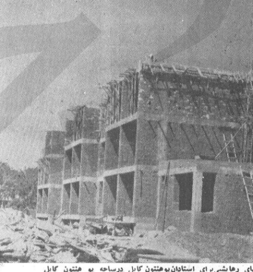
نمایی از جریان کار ساختن ایپارتمانهای رها یی برای استادان پوهنتون کابل در ساحه پوهنتون کابل
