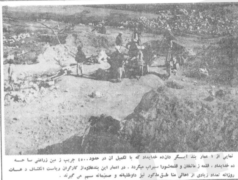
نمایی از اعمار بند ایسگر دانه خداید که با تکمیل آن در حدود ۴۰۰۰ جریب زمین زراعتی ساخته شده خداید، قلعه ز ماخان و قلعه شورا سیراب میگردد. در اعمار این بنده علاوه از کارگران ریاست انکشاف در هات روزانه تعداد زیادی از اهالی مناطق مذکور نیز داوطلبانه و صمیمانه سهم می گیرند.
