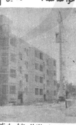
نمایی از ساختمان رها یی اسفادان پوهنتون کابل .
