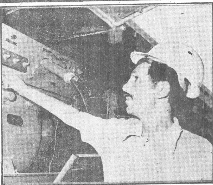
یک کارگر در حال تعمیر یک دستگاه پمپ در یک کارخانه.
