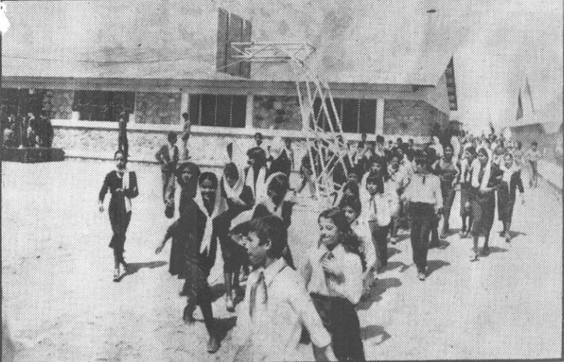
نمایی از مکتب سید نور محمد شاهینه که بوسیله ریاست ترانسپورت و ساختمان کابل اعمار گردیده و به وزارت تعلیم و تربیه اهدا شده است. عکاسی ح.ا.۱
