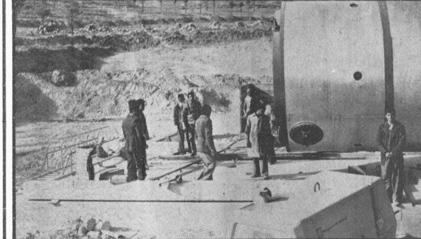
کار مو تناز دستگاه تولید انرژی برق سب استیشن شمال غرب شهر کابل هم اکنون جریان دارد. تکمیل این دستگاه که دارای قدرت تولید ۴ هزار کیلو وات انرژی برق است، نیاز شهر یان کابل به انرژی برق مرفوع میگردد. عکاسی ح.ا.ث
