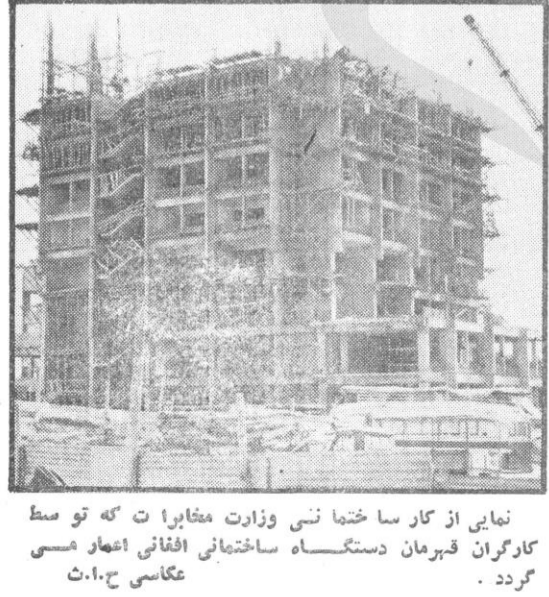
نمایی از کار ساختمانی وزارت متفارات که توسط کارگران قهرمان دستگاه ساختمانی افغانی اعمار می گردد. عکاسی ح. ا. ت.
