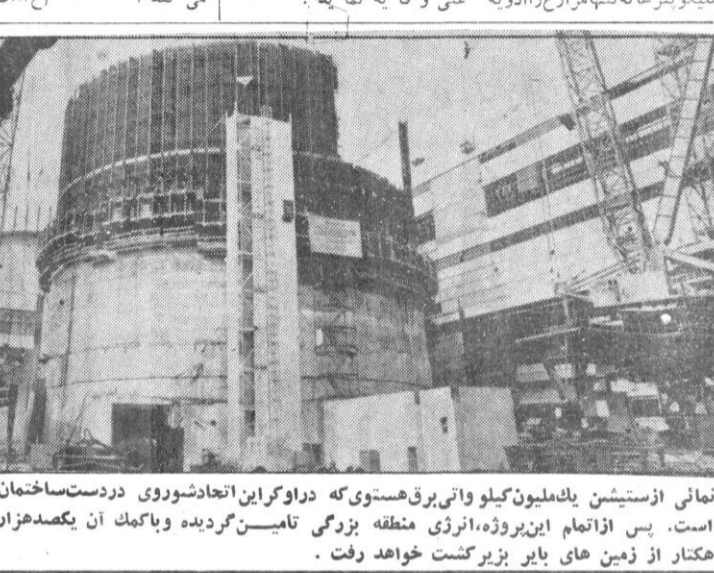
نمایی از ستیشین یک میلیون کیلوواتی برق هستوی که در اوکراین اتحاد شوروی در دست ساختمان است. پس از اتمام این پروژه، انرژی منطقه بزرگی تامین گردیده و با کمک آن یکصد هزار هکتار از زمین های بایر بزرگشت خواهد رفت.
