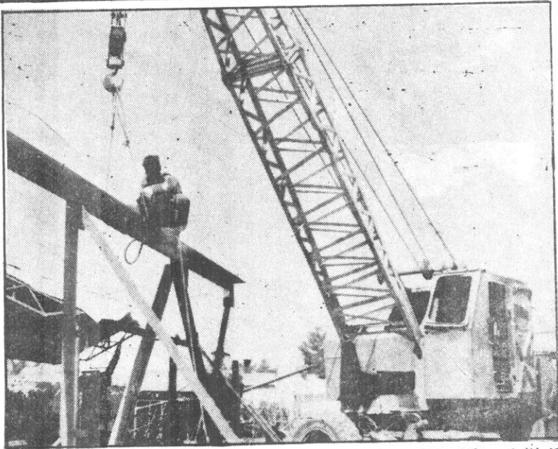
کارخانجات جنگلک از نخستین فابریکه های صنایع ثقلیه در کشور است. کار توسعه و تکمیل ایسفن فابریکه بغا طر بلند بردن ظرفیت تولیدی آن جریان دارد. عکس، انگر بزرگی رادر حال ساختمان نشان میدهد. عکاسی ح.ا.م
