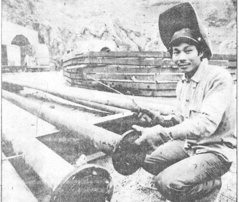
با کمک تخنیک اتحاد شوروی پروژه های صنعتی ویتنام در دست ساختمان میباشند. مجتمع برق آبی هوا بیسن که بزرگترین پروژه آسیای جنوب شرقی است در میان این پروژه ها قرار دارد. در عکس فام وان دکنگیک از کارگران این پروژه
